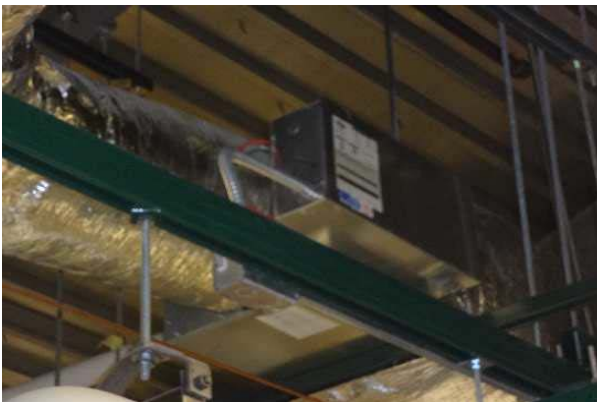
#41: VARIABLE AIR VOLUME (VAV) UNIT
